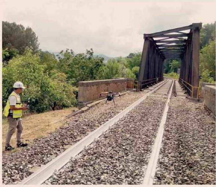
Tecnologie per la sicurezza. Ispezione con un drone lungo la rete ferroviaria
