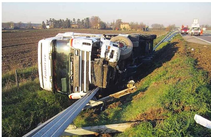
**2A e 2B.** Una barriera installata in situ (2A) e suo comportamento in seguito a un impatto da parte di un veicolo (2B)
